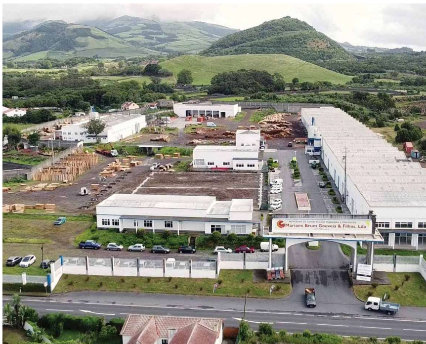
Central de Madeiras da empresa está localizada na Estrada Regional da Ribeira Grande
